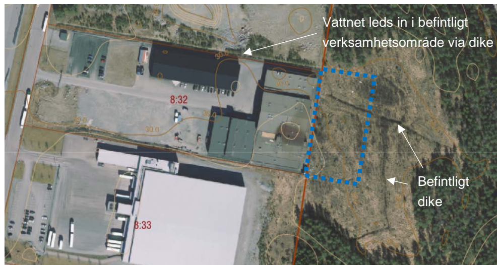
Bilden ovan visar ett ortofoto från 2020 (med höjdkurvor) över den aktuella delen av Sneden S:1 och fastigheten Stenvreten 8:32 som den önskas föras över till.
